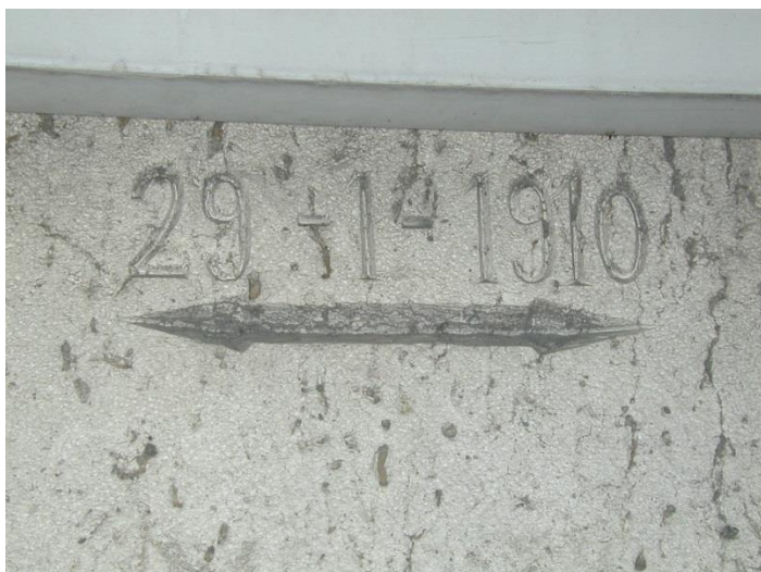
Repère de crue quai des Carrières
